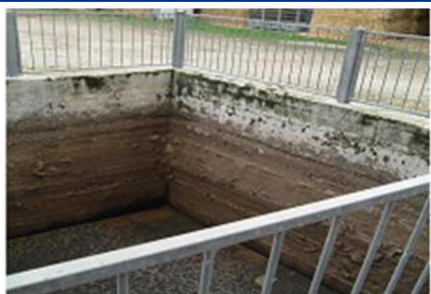
Foto 2 – 3 Parapetti correttamente installati
